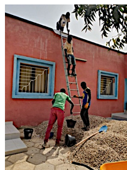
in 2 Tagen 10m3 Kies aufs Dach kübeln
